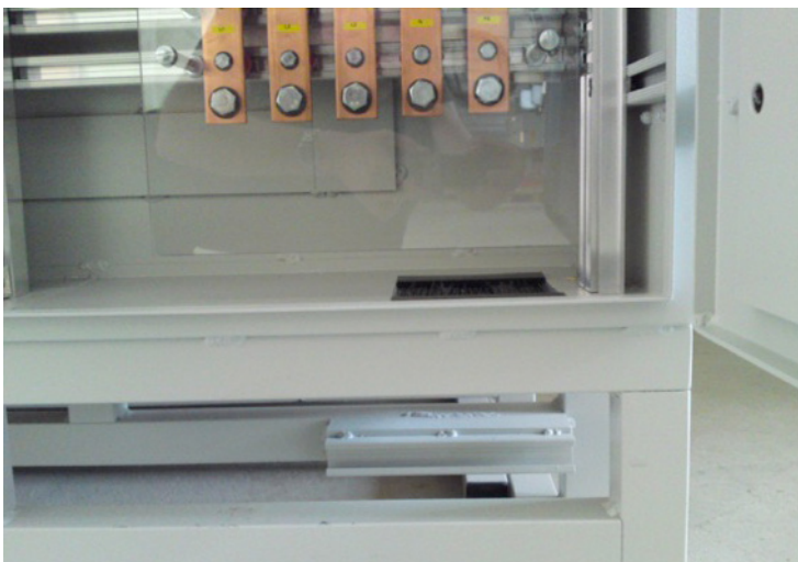
Einführung des Installationskabels
